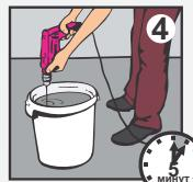
Для подготовки раствора залейте водопроводную воду комнатной температуры в чистую ёмкость из расчёта 4,5 - 5,5 л воды на 1 мешок (25кг). Засыпьте сухую смесь в воду, перемешивайте раствор дрелью со специальной насадкой на низких оборотах до получения однородной массы. Подождите 5 минут, после этого перемешайте вторично. Время пригодности раствора к работе не менее 3 часов.
